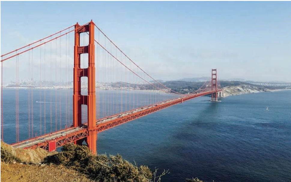
4.6 : Le pont du Golden Gate, à San Francisco
