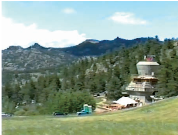
3.25 : Le Grand Stupa en construction
