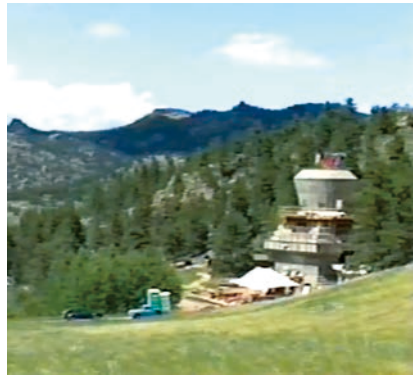
圖 3.25: 修建中的大塔
